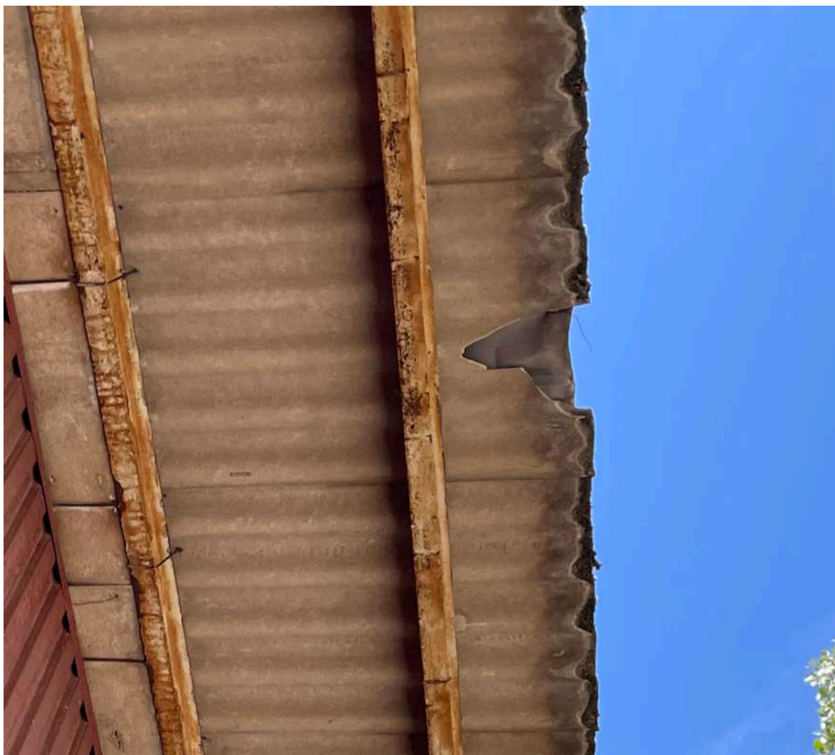
Figura 2. Borde de alero lado norte.
