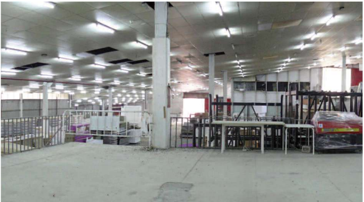
Interior del pabellón, con el paso del tiempo.
