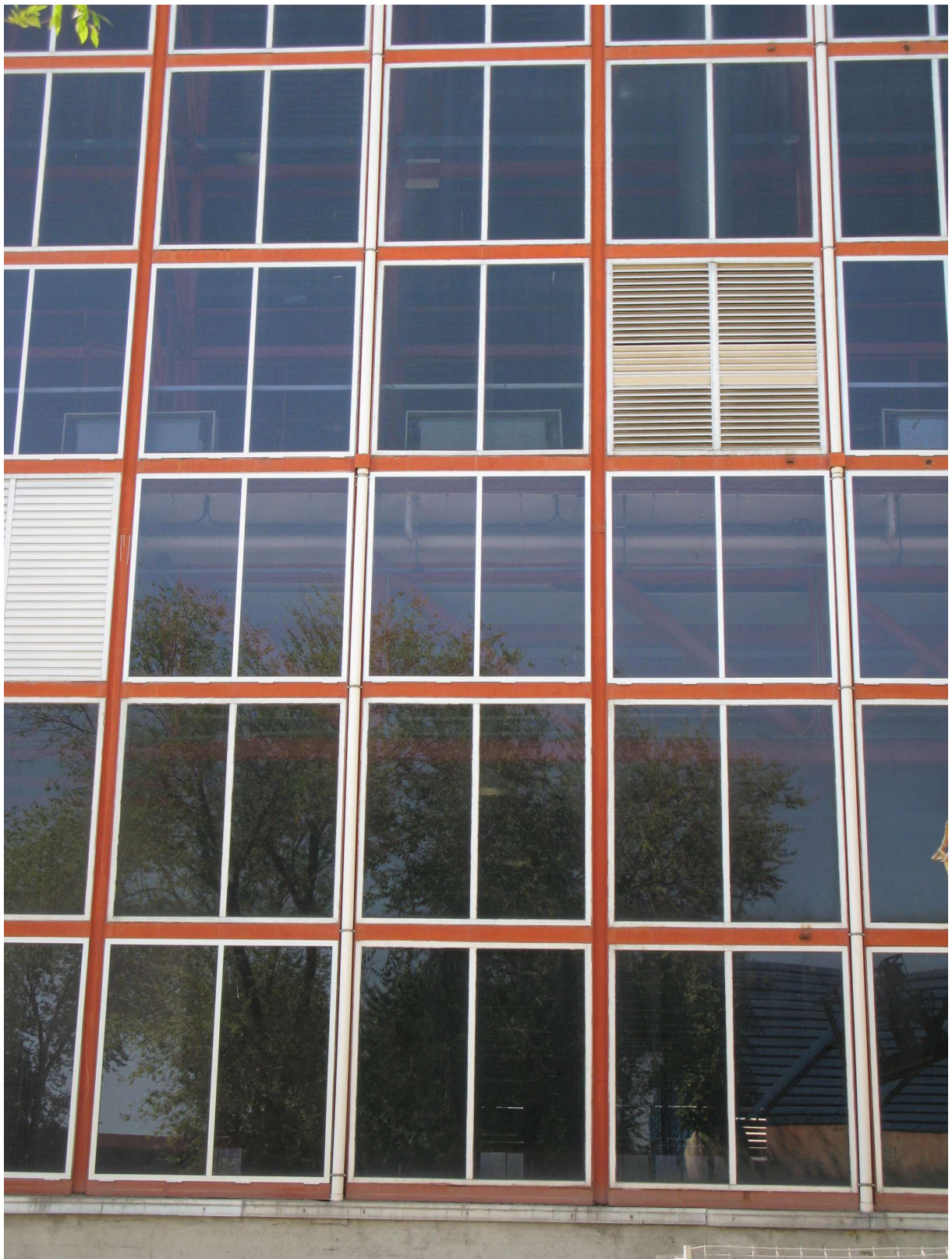
Detalle de Fachada
