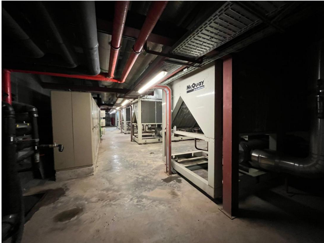
Sala máquinas Industrial I. Vista interior longitudinal desde puerta de acceso
