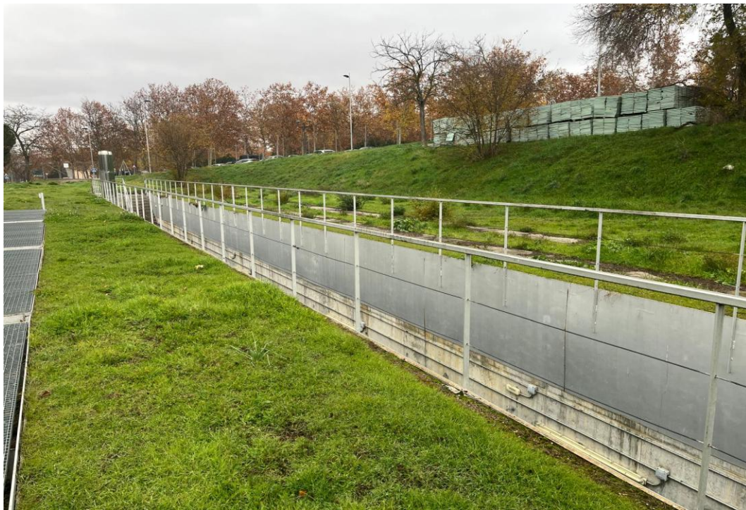
Bajada peatonal a Zona Industrial I. Vista desde exterior
