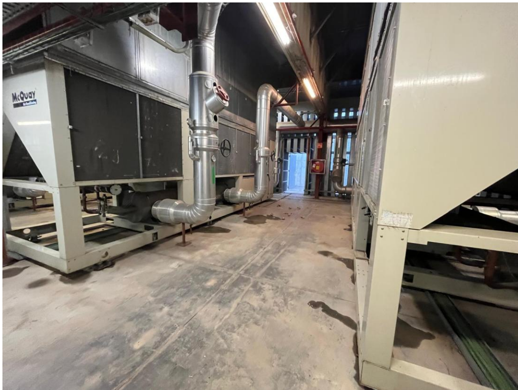
Sala máquinas Industrial I. Vista interior transversal
