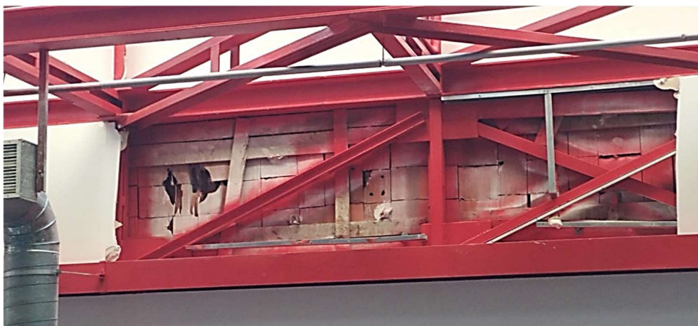
Situación forjado tras el descuelgue y retirada del falso techo. Pabellón Cristal
